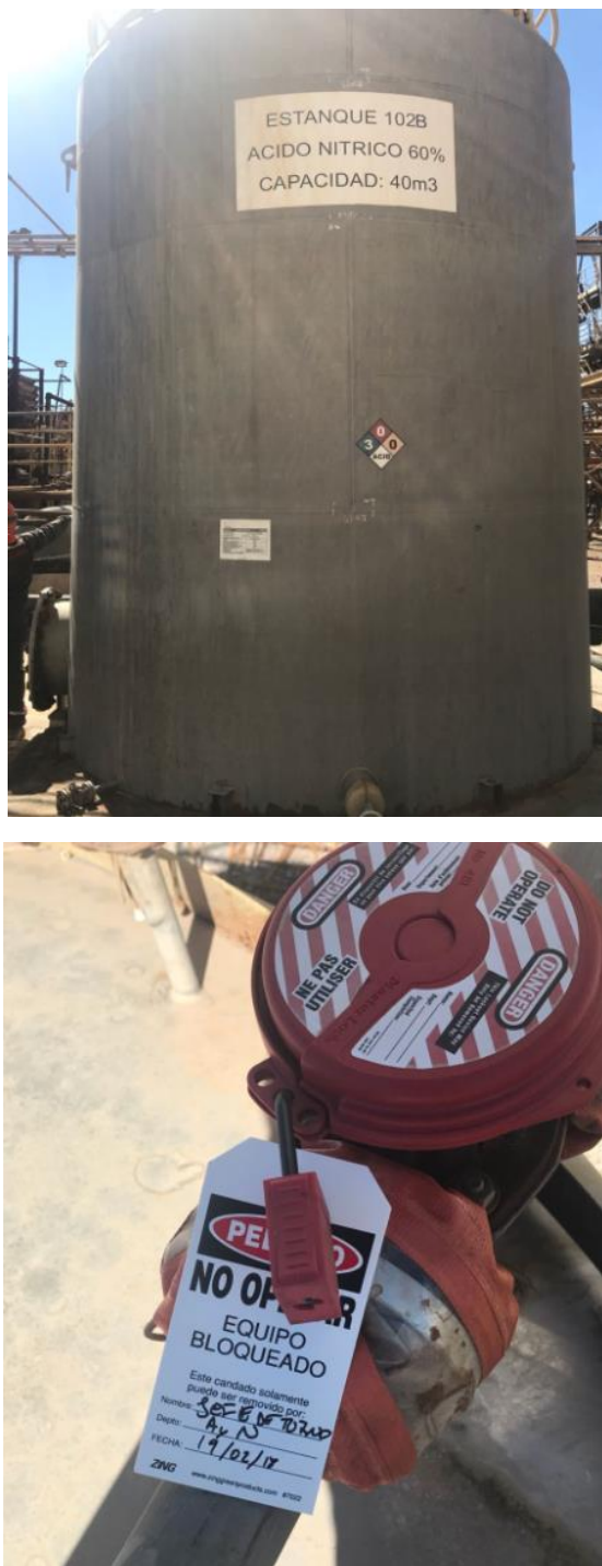
Ilustración 2 Registro Fotográfico de Bloqueo a Estanque 102 B de Capacidad 53.000 kg, que almacena HNO 3 al 60%
